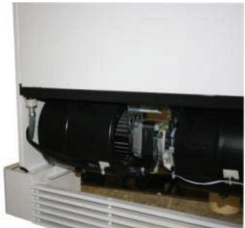
5 Connettere i cavi di alimentazione e dell'eventuale umidostato remoto.
