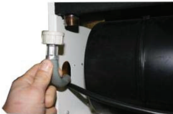
3 Collegare il tubo scarico condensa.
