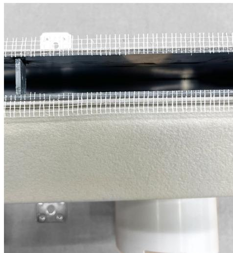
NOTA: le due foto si riferiscono a due LINE-S (uno da 1000 mm e uno da 500 mm) in cui i collari/collarini sono stati portati, in cantiere, dalla posizione posteriore alla posizione laterale.
