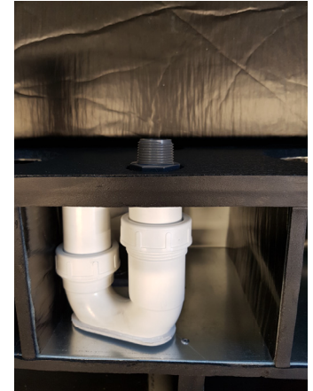
REGOLAZIONE DELL'ALTEZZA DEL TUBO BIANCO (VISTA SOPRA)
