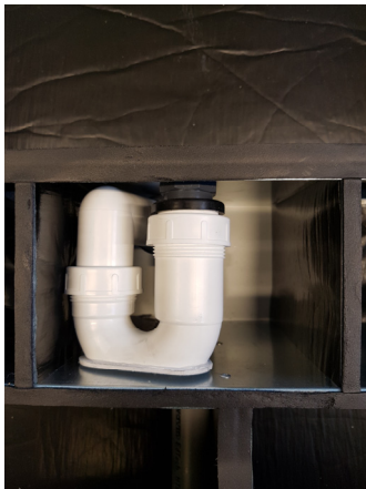
INSERIMENTO DEL RACCORDO NELLA GUARNIZIONE
