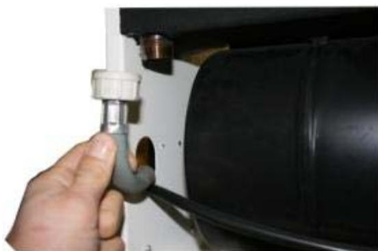
3 Collegare il tubo scarico condensa.
