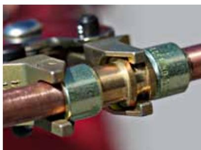
FIGURA 10. PRESSATURA FASE 2: la pressatura deve essere eseguita in maniera fluida, verificando che il giunto non vada fuori asse.
