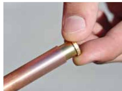
FIGURA 6. INSERIMENTO INSERTO: l'inserto di stabilizzazione è obbligatorio su tutte le linee frigorifere in rame cotto, consigliato sulle linee frigorifere in rame crudo.
