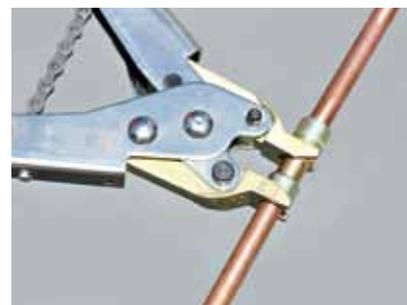
FIGURA 9. PRESSATURA FASE 1: avendo cura di mantenere il giunto spinto verso il tubo iniziare la pressatura.
