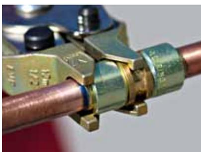
FIGURA 11. PRESSATURA FASE 3: la pressatura termina quando l'anello arriva in battuta, si avverte chiaramente, l'indurimento della pinza.
