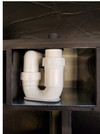
REGOLAZIONE DELL'ALTEZZA DEL TUBO BIANCO (VISTA SOTTO)
