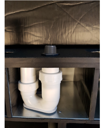
REGOLAZIONE DELL'ALTEZZA DEL TUBO BIANCO (VISTA SOPRA)
