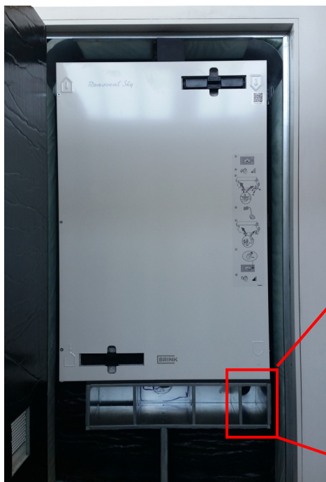
UNITA' DI VENTILAZIONE INSTALLATA NEL SILENT COMPACT BOX
